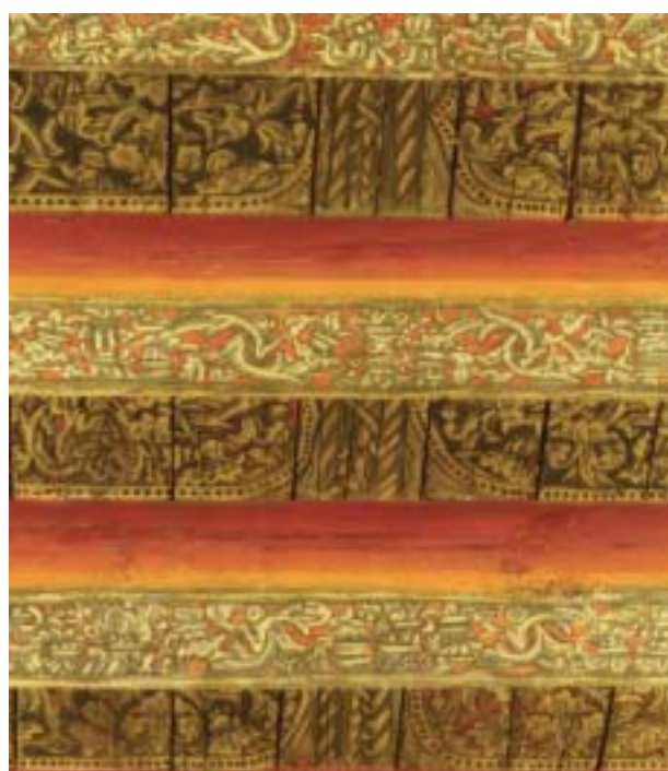
Plafond à caissons rehaussés de peinture et d'or © P. Aimar
